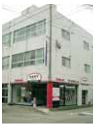
LPガス・灯油・富山米住宅設備工事 大沼燃料店 小矢部市中央町2-30 TEL・FAX 67-17 09
